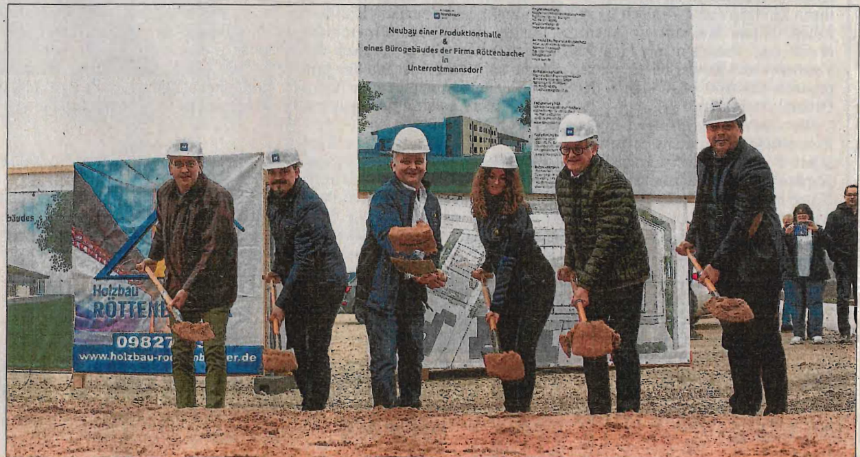
Dr. Jürgen Ludwig (von links), Markus Nehmer, Martin Röttenbacher, Xenia Löffler, Rainer Dippold und Rene Fabian beim symbolischen Spatenstich auf dem Betriebsgelände. Foto: Tizian Gerbing
